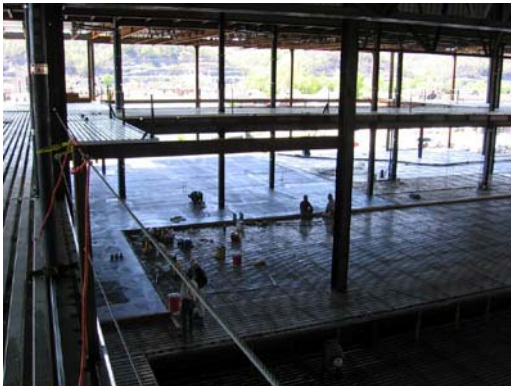
Figure 6 – 1 st Floor slab pour underway
