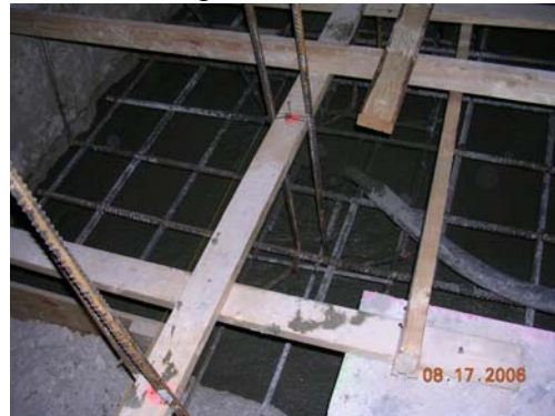
F5. Earthen Form Footing Pour
