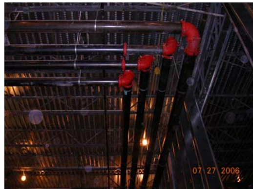
Fig. 3. Sprinkler Mainlines
