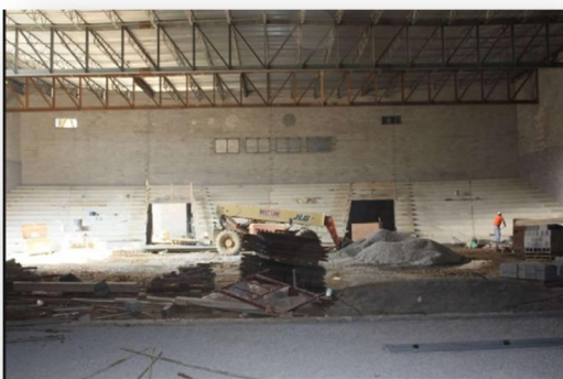
Fig. 3 Precast Auditorium Risers
