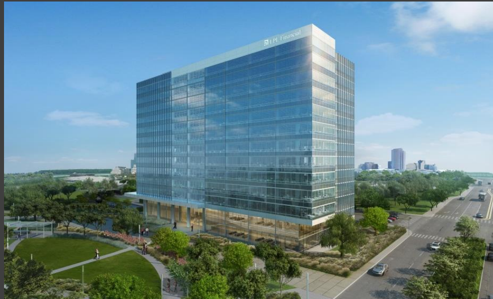
La Jolla Commons Phase II Office Tower
